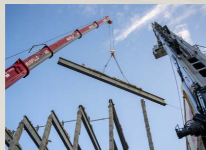
Entfernung Stahlträger
