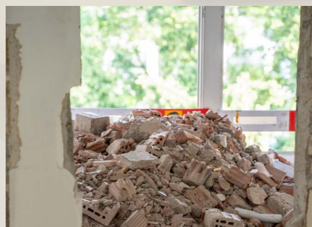
Rückbau und Schadstoffsanierung im Gebäudeinnern
