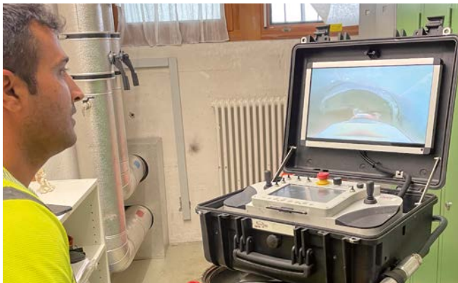
Kamerainspektion der Leitungen während der Sanierungsarbeiten.
